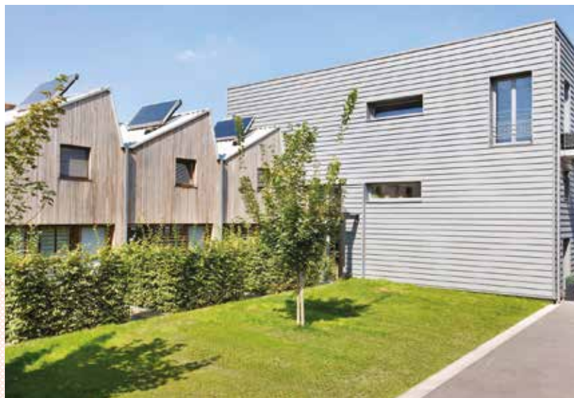
▲ APRÈS Logements en duplex et lofts.
