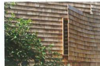
▲ Des bardeaux recouvrent l'ensemble des parois extérieures.
