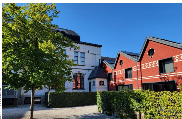
Les toitures à sheds (en dents de scie, qui couvraient en général des ateliers industriels) ont été maintenues.
