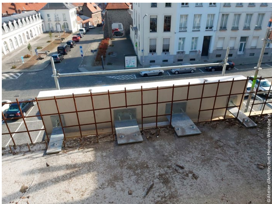
Montage van de gevelpanelen tegen de achterliggende betonstructuur
